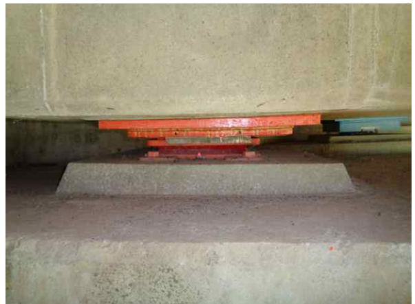
교량 받침 가동량 측정
